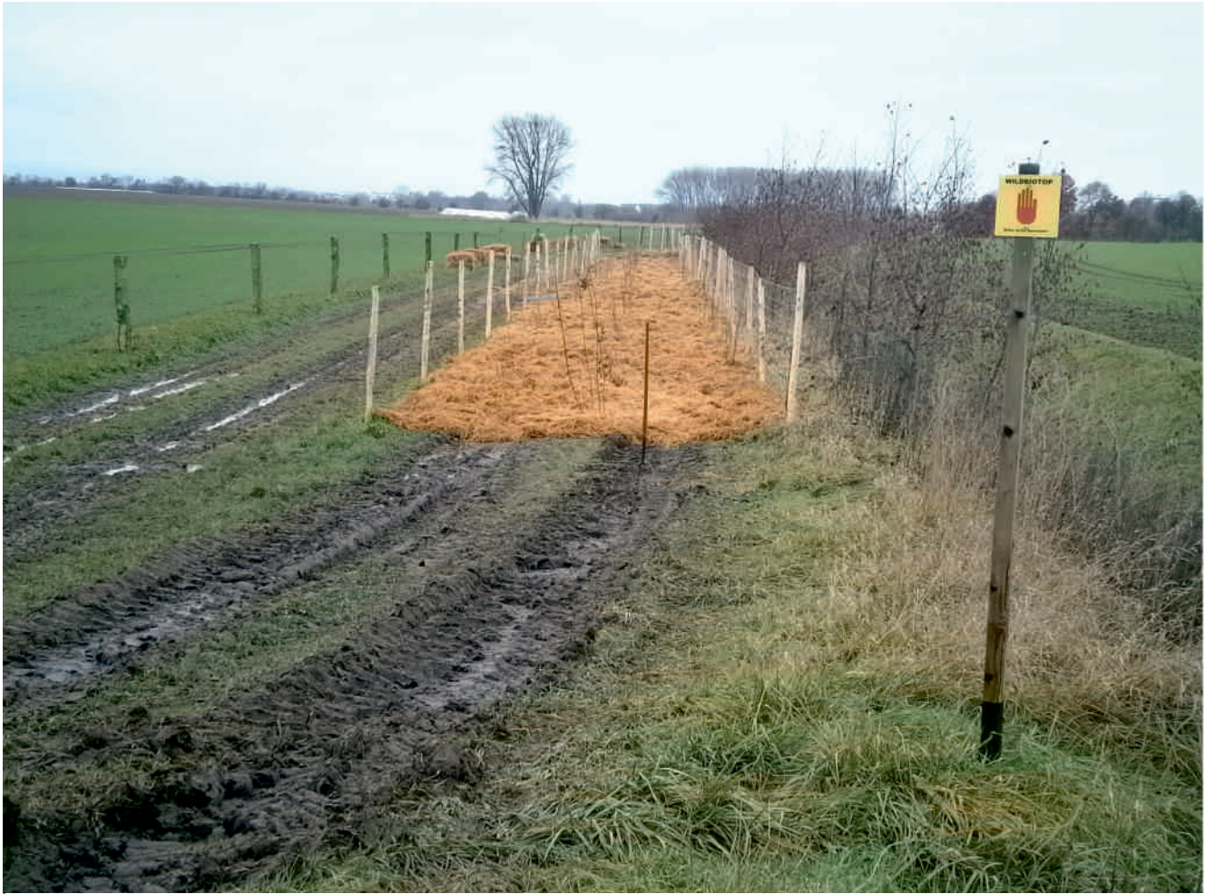
In Teilbereichen wurden angrenzend an die mit Schilf und Erlen bestandene Gewässerböschung dreireihig Sträucher gepflanzt.
