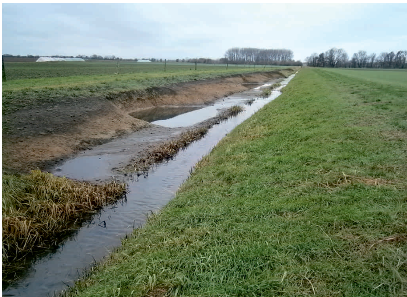
Feuchtbermen sollen bei Starkregen Hochwasserspitzen aufnehmen.
