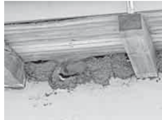
Wo für ein neues Nest kein Platz mehr ist, wird ein altes ausgebessert.
