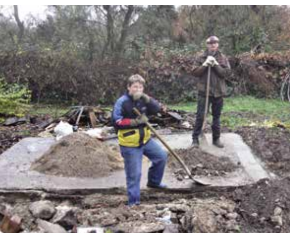
Auf diesem Fundament wird später unsere neue Hütte stehen!
